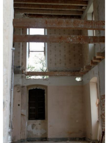
À l'intérieur, les cloisons ont été démolies. La seconde dalle a été coulée mi-octobre et la réfection du toit est en cours. Le chantier devrait durer jusqu'à la fin de l'été 2025. À terme, le bâtiment comprendra deux locaux associatifs au rez-de-chaussée et deux logements aidés en duplex à l'étage.
